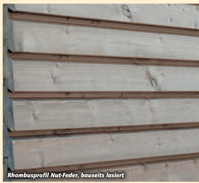
Rhombusprofil 27 x 68 mm, Douglasie unbehandelt, mit Außeneckleisten 42 mm
