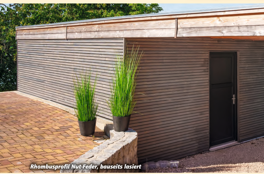
Rhombusprofil 27 x 68 mm, Douglasie unbehandelt, mit Außeneckleisten 42 mm
