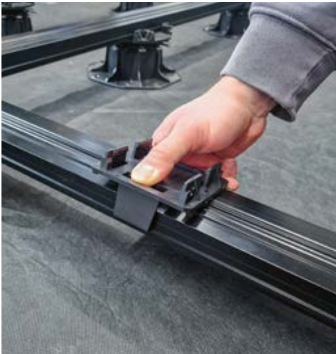
KL-Kreuzverbinder auf die ausgerichtete Konterlattung einklicken
