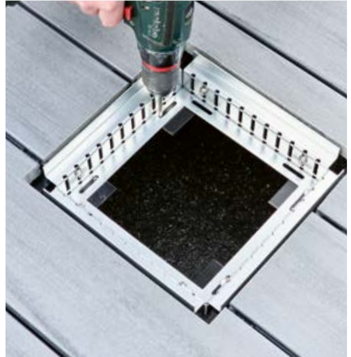
Revisionskasten einsetzen und an Windlastträger verschrauben
