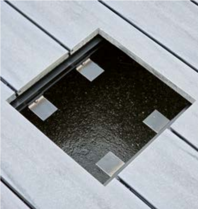
Windlastträger an der Alu-UK befestigen
